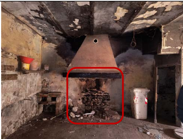
02. Ambiente A8 in muratura a ciottoli a spina di pesce
