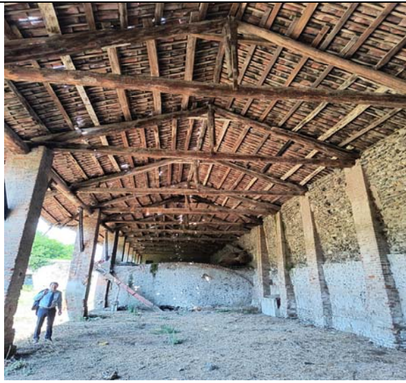
06. Sequenza dei contrafforti. Foderatura della muratura alla base
